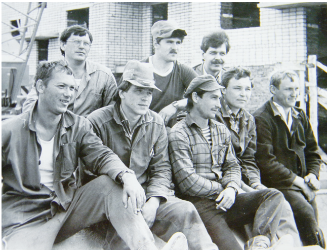
На строительстве МЖК.
